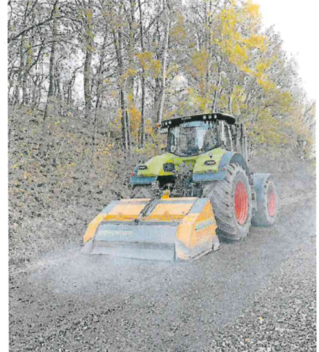
Die Fräsarbeiten bei Wolfersweiler sind in vollem Gange. FOTO: BERND ZOLLHÖFER
