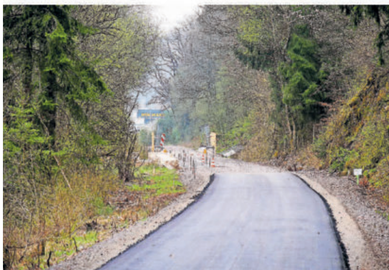
Teilweise ist die neue Trasse bereits asphaltiert.
