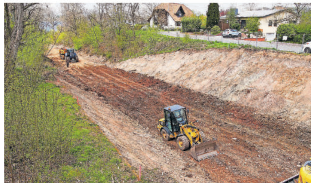
Da haben die Bagger, Planiermaschinen und Radlader viel zu tun: In Freisen wird die Radweg-Trasse freigeschaufelt.
