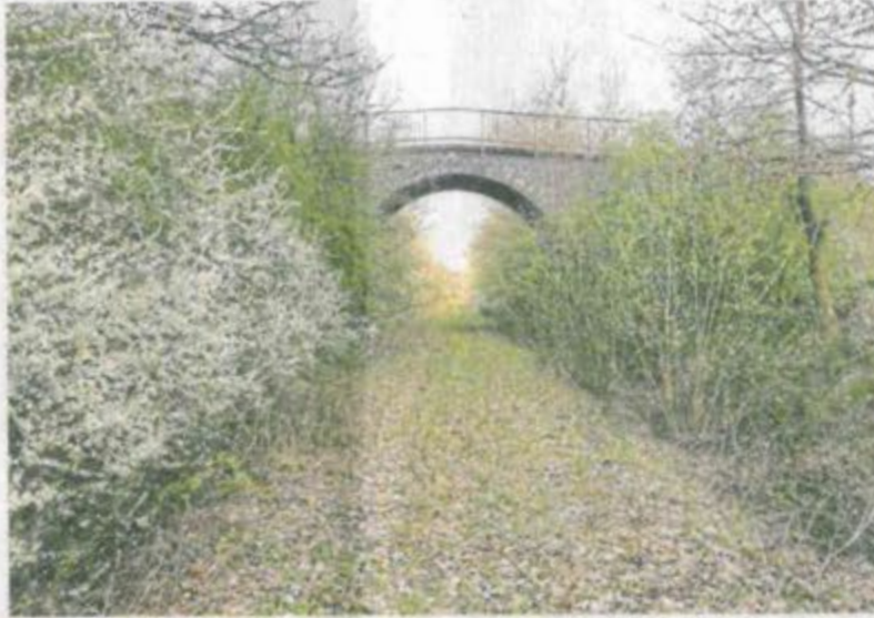
Bei Freisen sind die Gleise bereits demontiert. Hier sollen die Arbeiten am neuen Freizeitweg im Frühjahr beginnen. Foto: Kreisverwaltung St. Wendel
